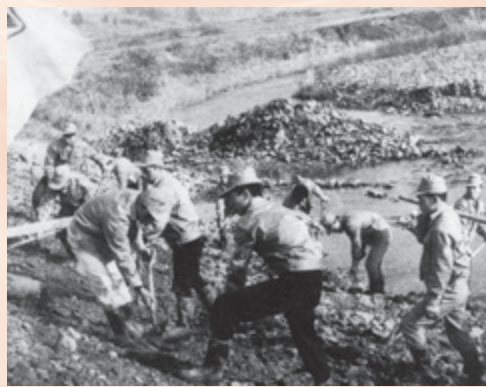
（写真3）産業開発青年隊運動、尾花沢青年建設班による野尻川改修工事（1961年）
